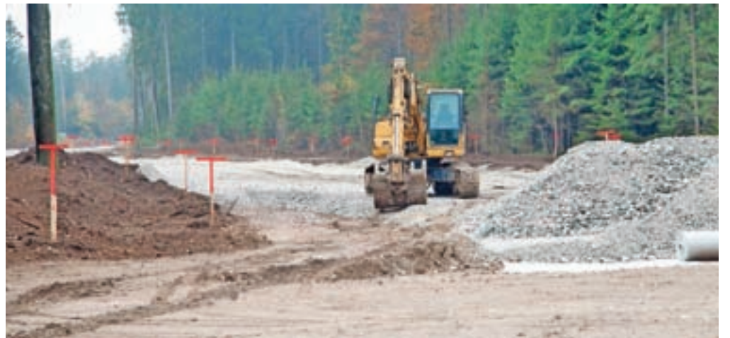
Septembra se je končalo dolgoletno čakanje na začetek gradnje obvoznice mimo letališča.
